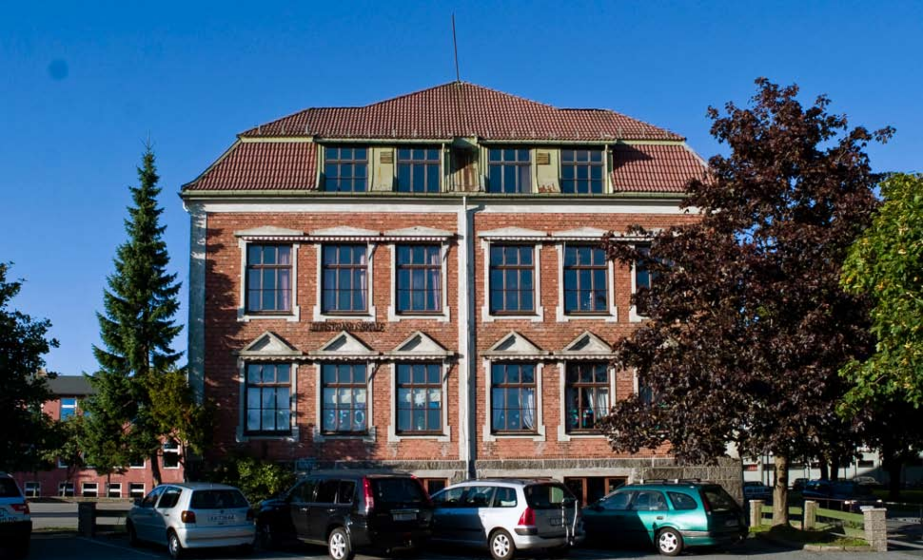
Torstrand skole fasade mot syd. Herregården til venstre for bildet.
