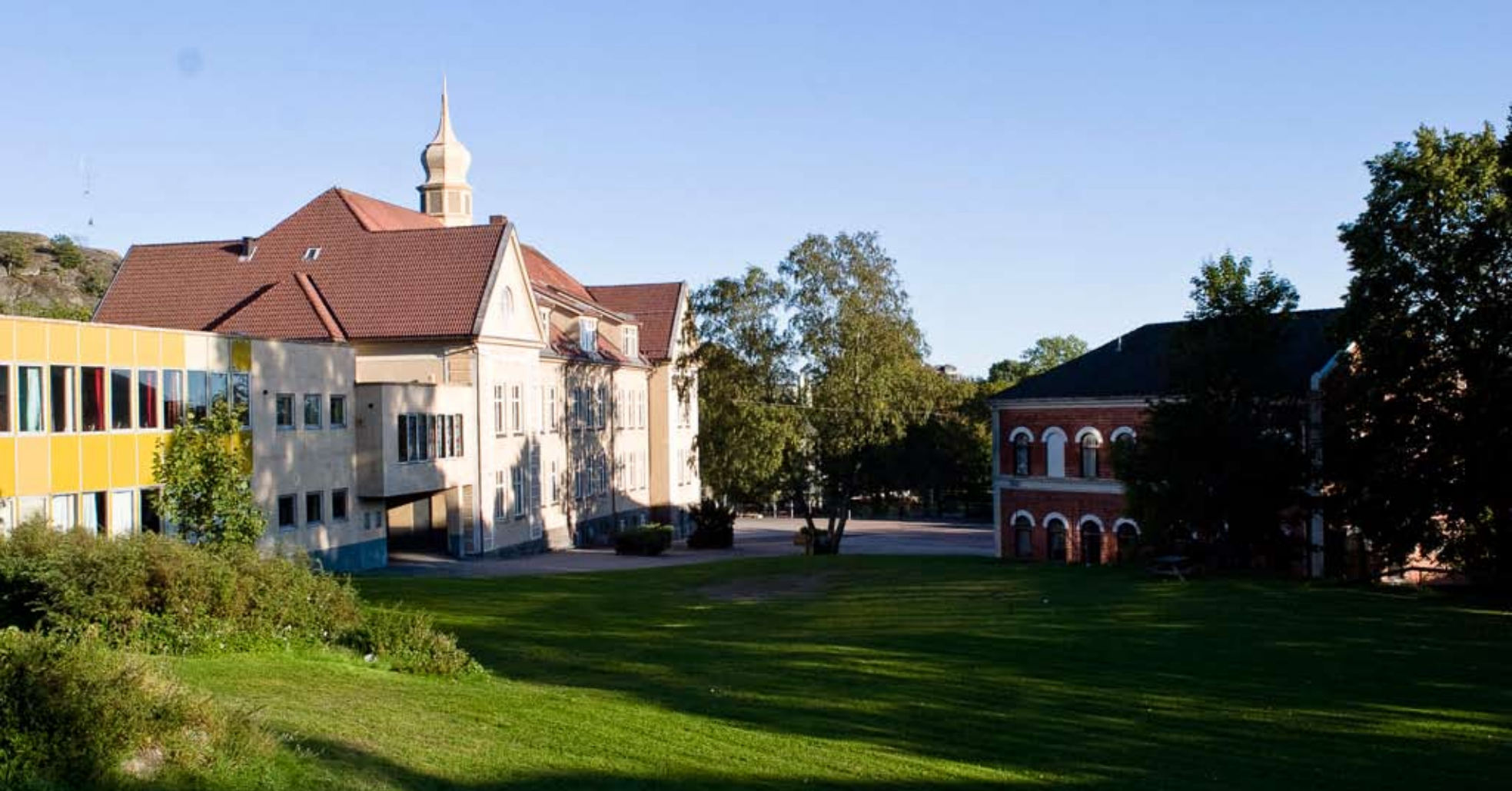
Det opprinnelige parkarealet sett ovenfra "stenhuset" plassering.
